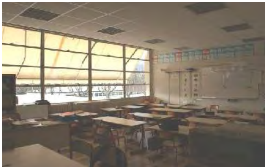
Salle de classe (photo de l'existant)
