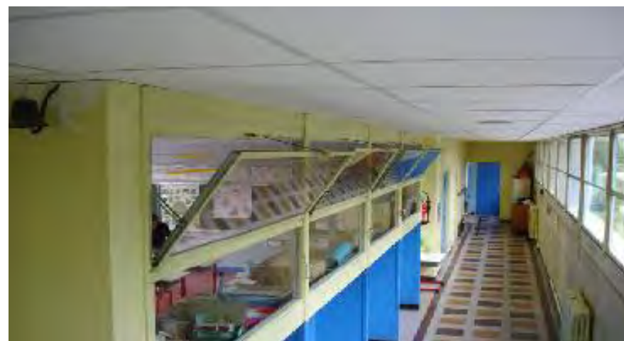
Couloir Nord (photo de l'existant)
