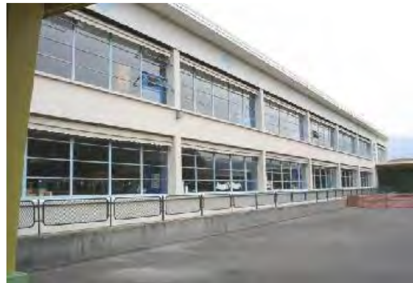
Façade Sud (photo de l'existant)
