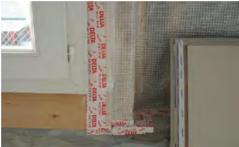
Étanchéité structure bois
