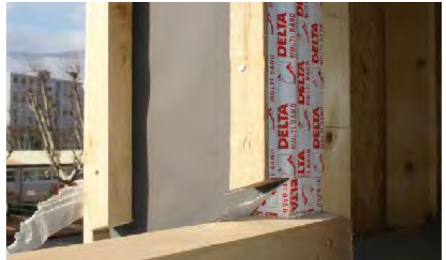
Détail d'étanchéité à l'air
