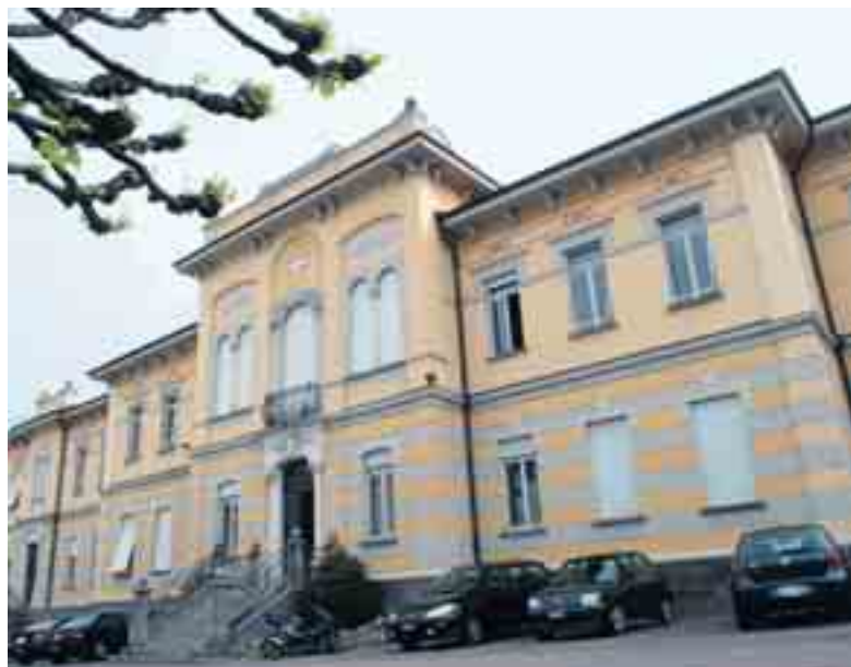
Anche in Municipio è in funzione un impianto di telegestione delle caldaie. (Gianinazzi)
